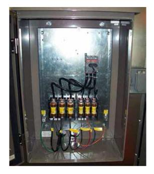
FIGURE 61 - SINGLE POINT POWER CONNECTION
