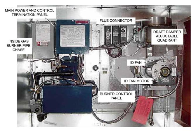
FIGURE 67 - GAS BURNER COMPONENT LOCATIONS
