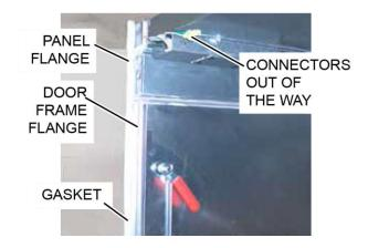
**FIGURE 32 -** USE GASKET (P/N 028-11873-010) TO DOOR FRAME AT SHIPPING SPLIT
